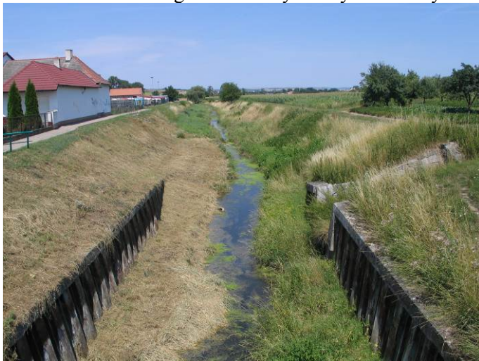
Foto 1: Pohled na regulované koryto řeky Trkmanky na severním okraji zástavby Kobylí.
