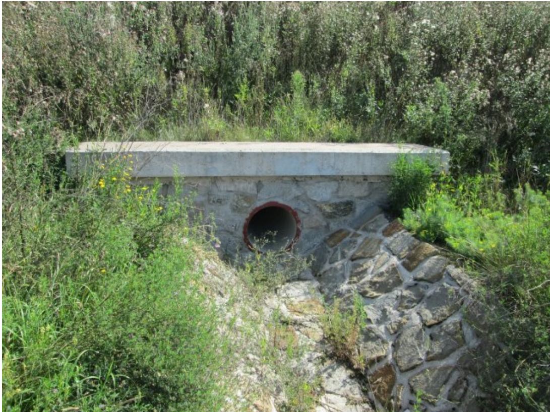
Obr. 11: Výpustný otvor suché nádrže v k.ú. Hustopeče a k.ú. Kurdějov
