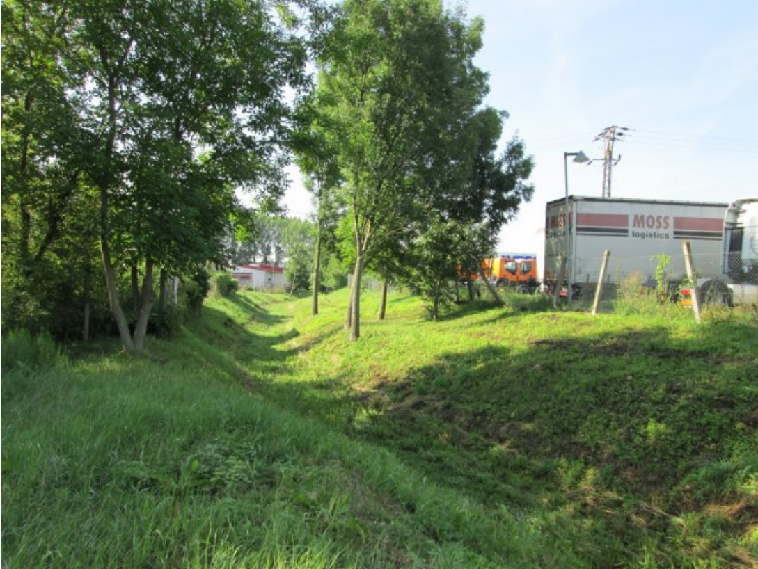
Obr. 5: Koryto vodního toku v intravilánu města Hustopeče - možné levostranné vybřežení toku
