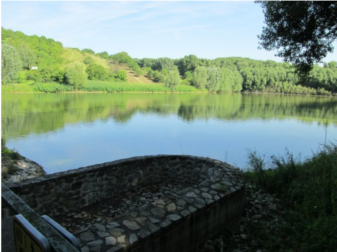
Obr. 3: Bezpečnostní přeliv Zadního rybníka
