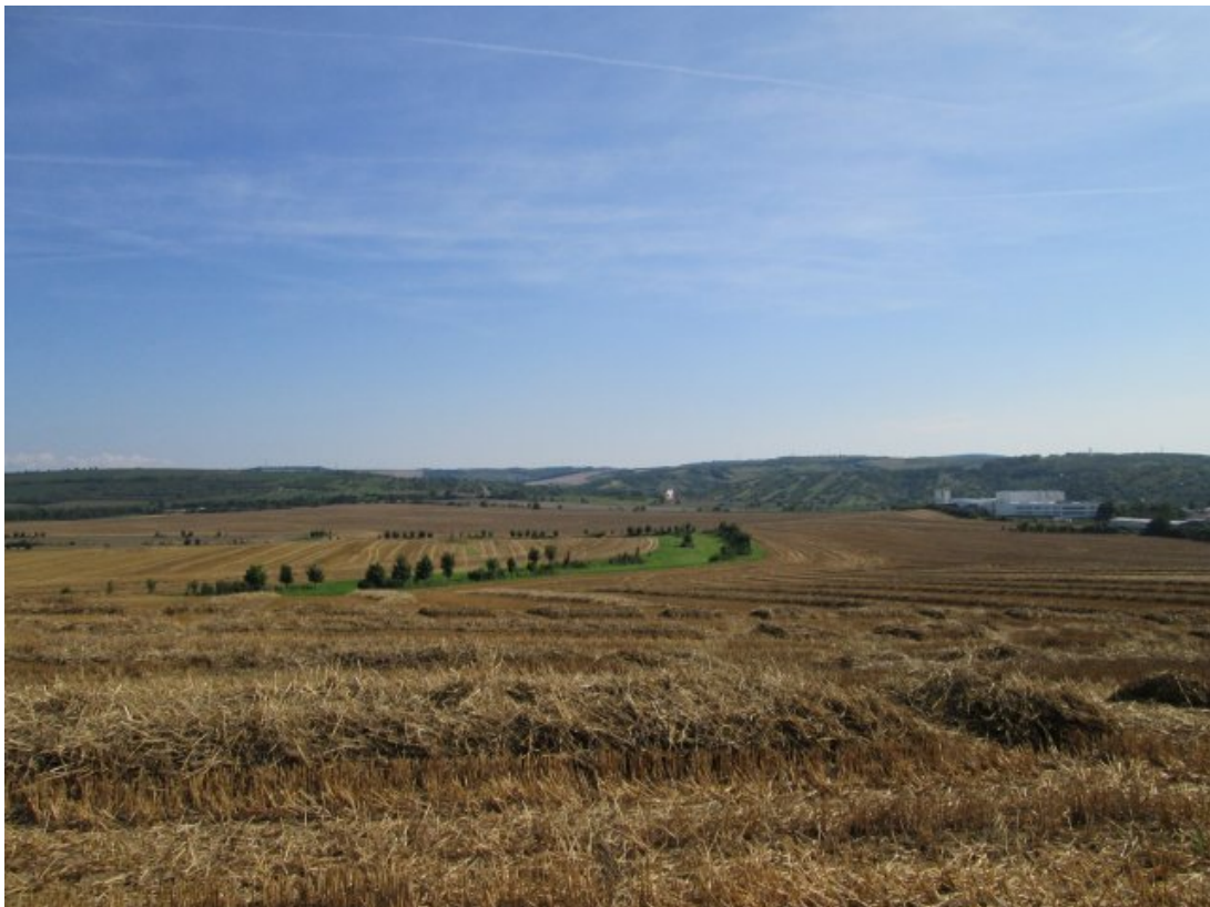
Obr. 16: Svodný zatravněný příkop k suché nádrži v k.ú. Starovice
