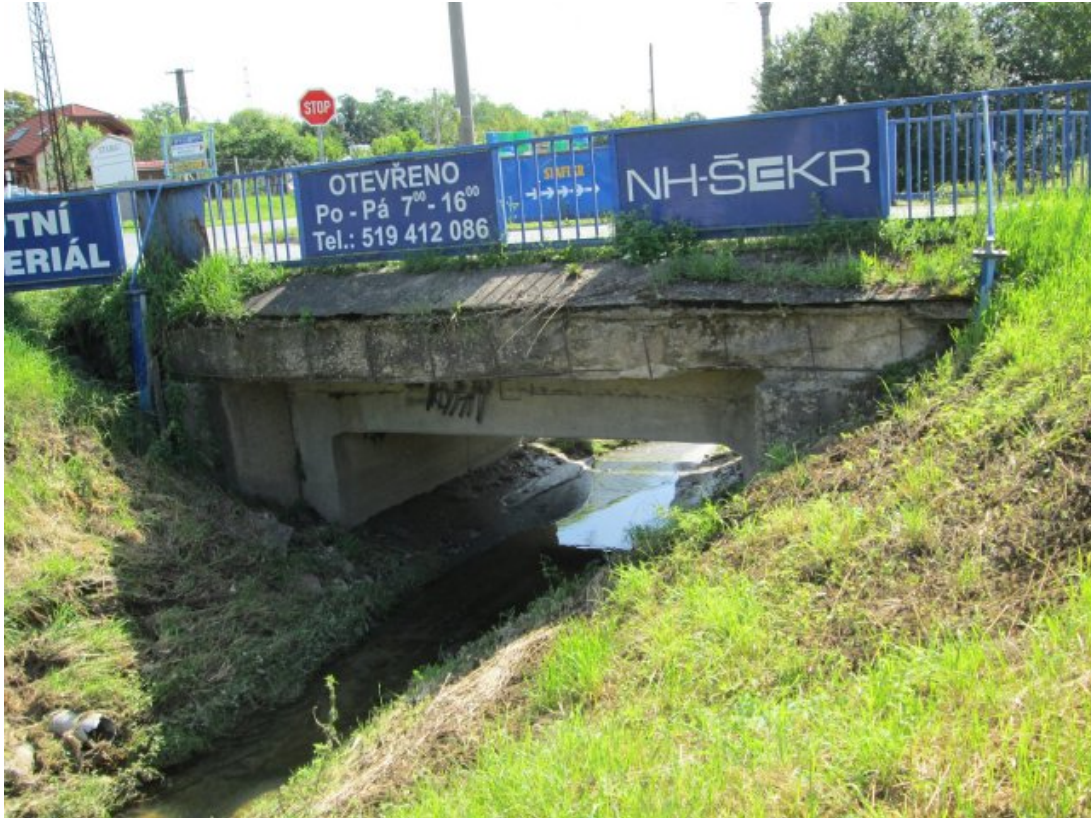
Obr. 13: Most u železničního přejezdu
