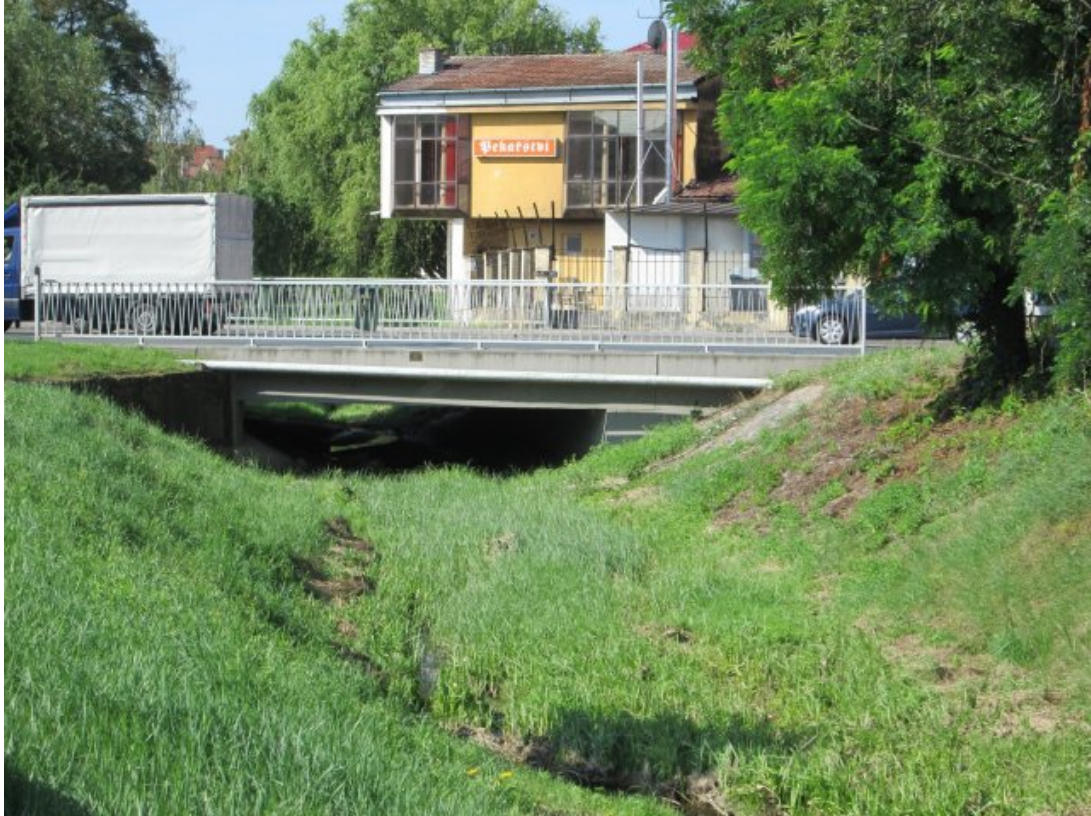
Obr. 9: Most na silnici č. 425
