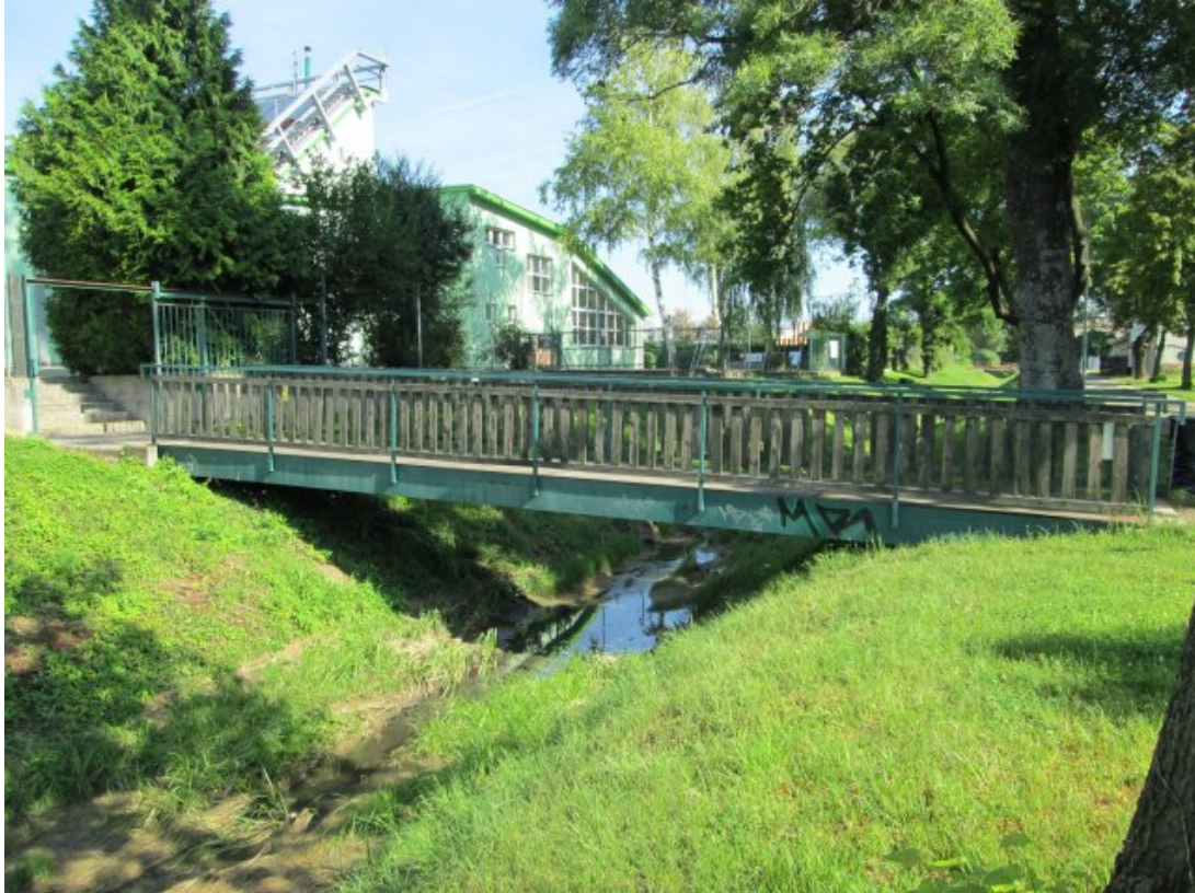
Obr. 7: Lávka omezující odtokové poměry
