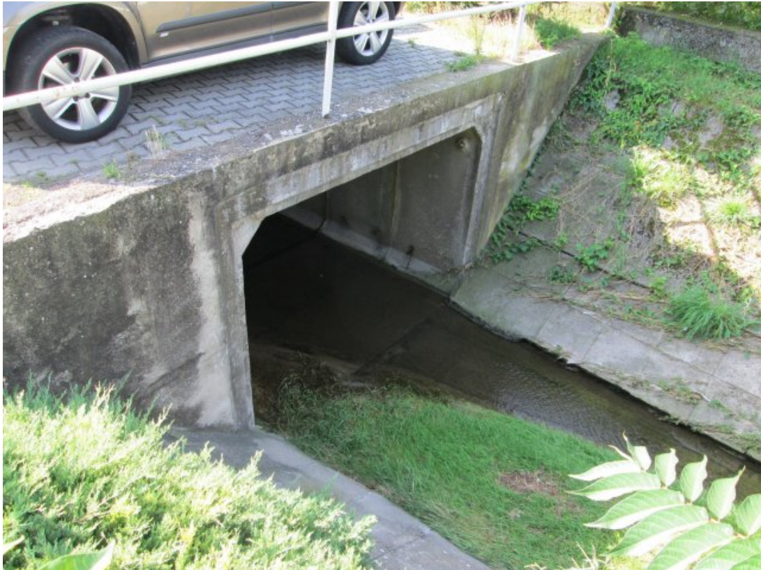
Obr. 15: Zatrubnění vodního toku Štinkovka v intravilánu města Hustopeče
