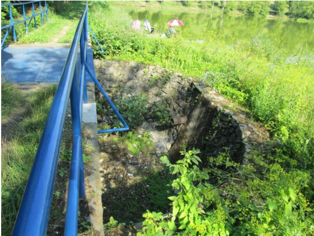
Obr. 1: Bezpečnostní přeliv Předního rybníka
