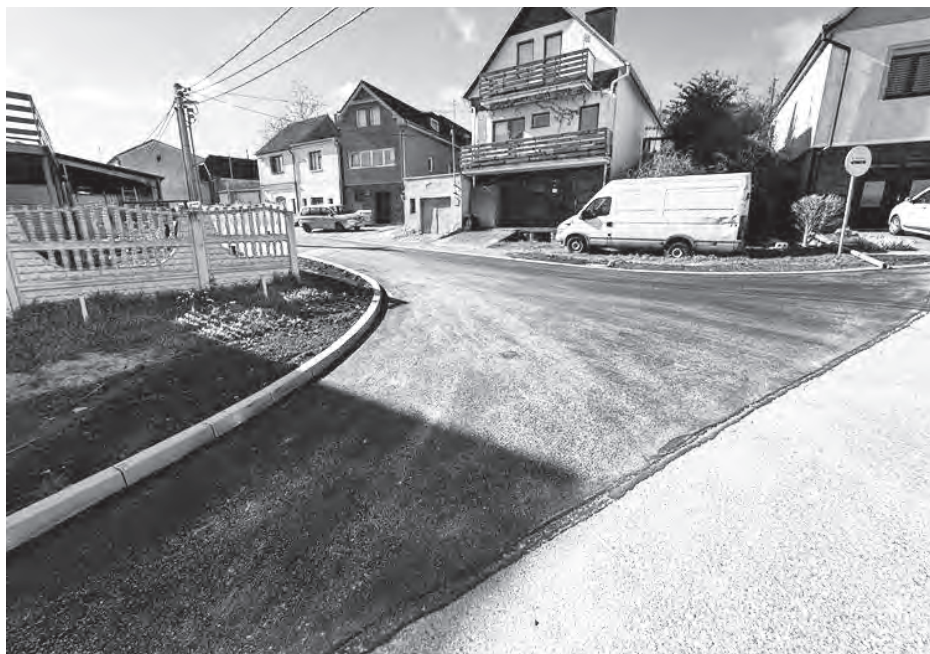
Hotová komunikace v ulici Vinařská.
