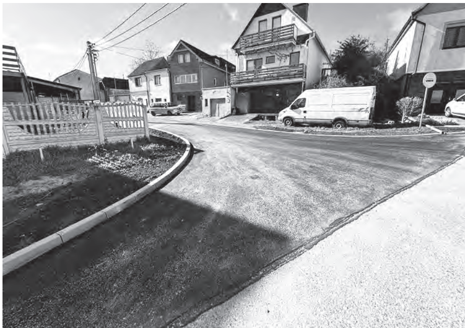
Hotová komunikace v ulici Vinařská.
