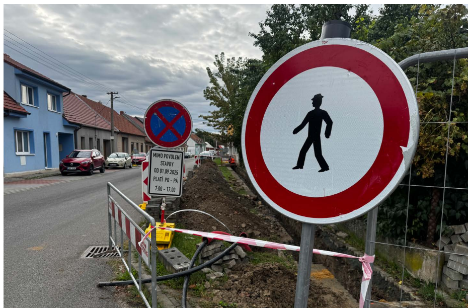
Práce v ulici Šafaříkova
