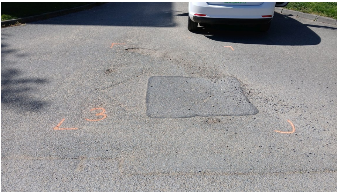
3, U Větrolamu - vybourání asfaltu + nová pokládka – cca 8 m 2
