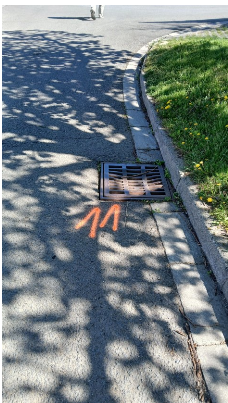
11 – 13, Vrchlického – 2x oprava vpustí + vybourání asfaltu + nová pokládka 2 m2
