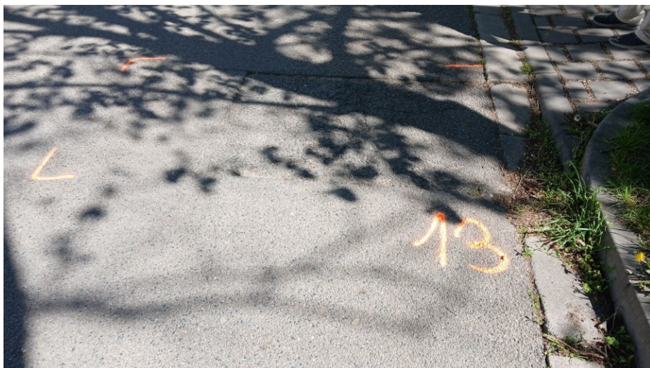
14, Nerudova - vybourání asfaltu + nová pokládka, cca 1 m2
