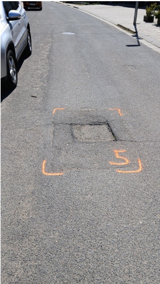
5, Pionýrská - vybourání asfaltu + nová pokládka – cca 1 m2
