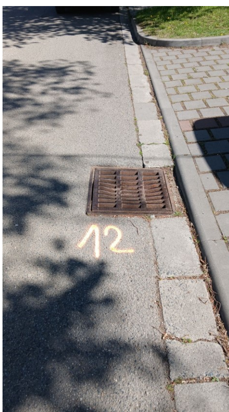
11 – 13, Vrchlického – 2x oprava vpustí + vybourání asfaltu + nová pokládka 2 m2
