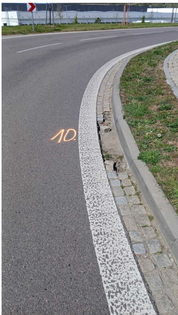
10, Žižkova ke Kauflandu – oprava přídlažby
