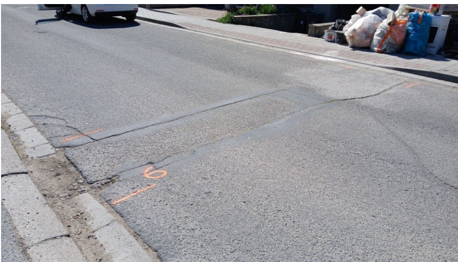
6 – 9 U Větrolamu, vybourání asfaltu + nová pokládka (cca 15 m2) + zalití spár
