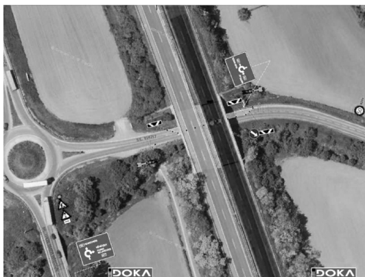
Rekonstrukce mostu ev. č. D2-032 2 od 5. 4. 2021 do 11. 4. 2021. Omezení na podjezdu číslo 420-001 (km 6.44 provozního staničení silnice II 420).
