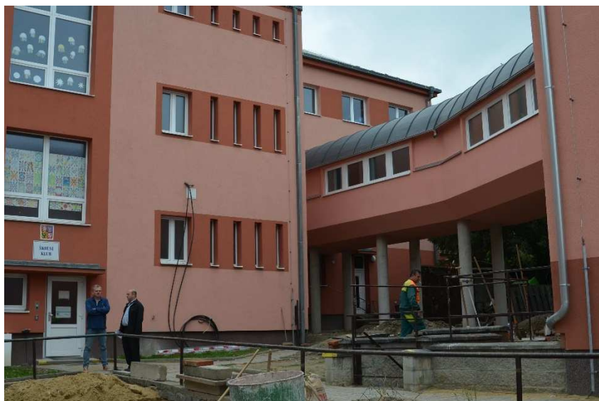
Spojovací krček propojil budovu dílen a hlavní budovu školy.
