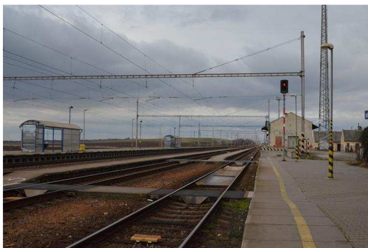
Vlakové nádraží v Šakvicích před rekonstrukcí.
