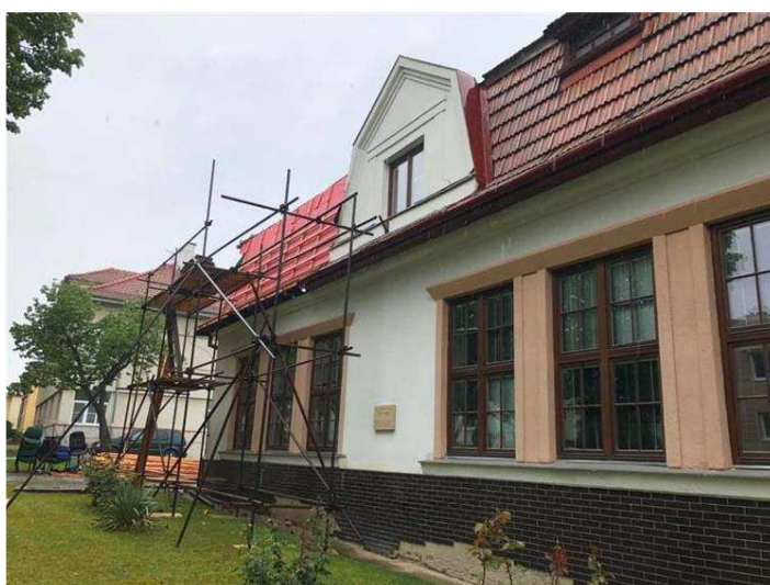
Základní škola Hustopeče má novou střechu.
