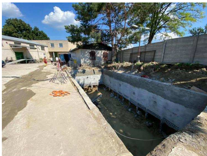
Stavba retenční nádrže v areálu Sběrného dvora.
