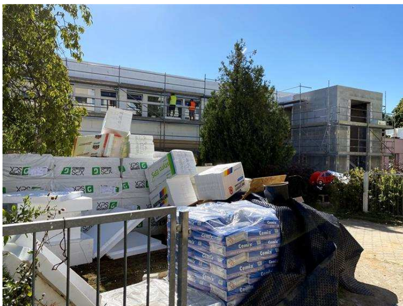
Školka během stavby nástavby.
