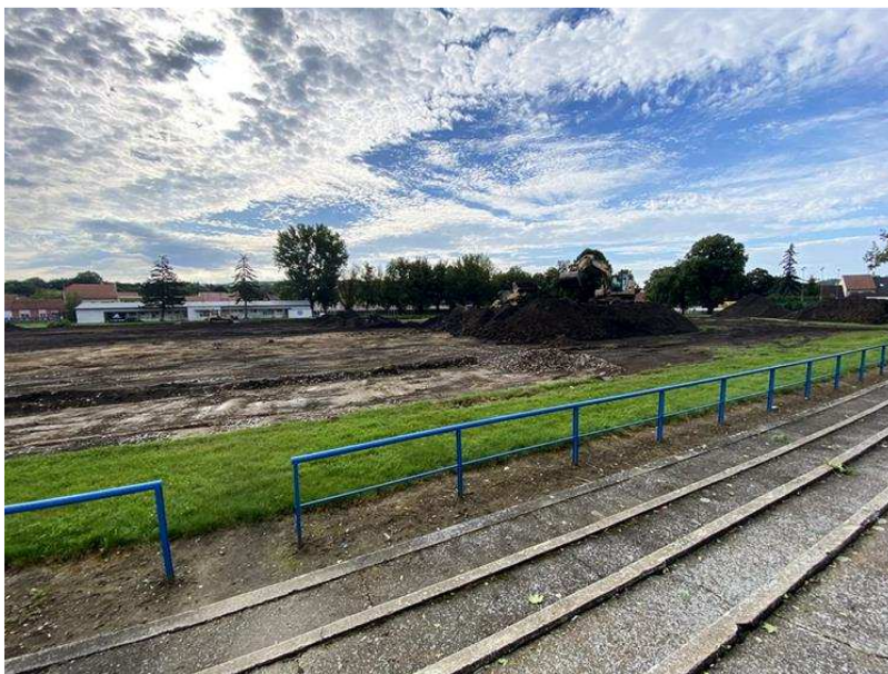
Práce na novém fotbalovém hřišti a atletickém oválu.
