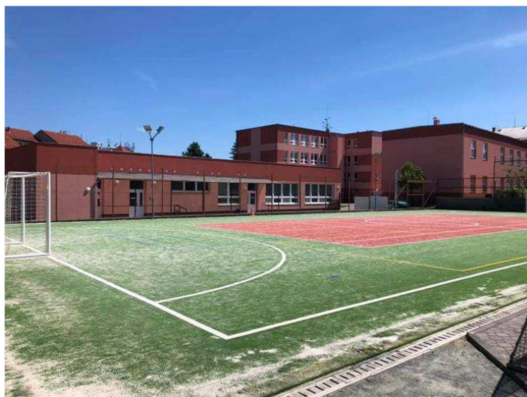
Střecha nafukovací haly poprvé od svého postavení splaskla.
