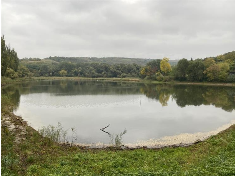
Stav předního rybníka před plánovanou opravou hráze.
