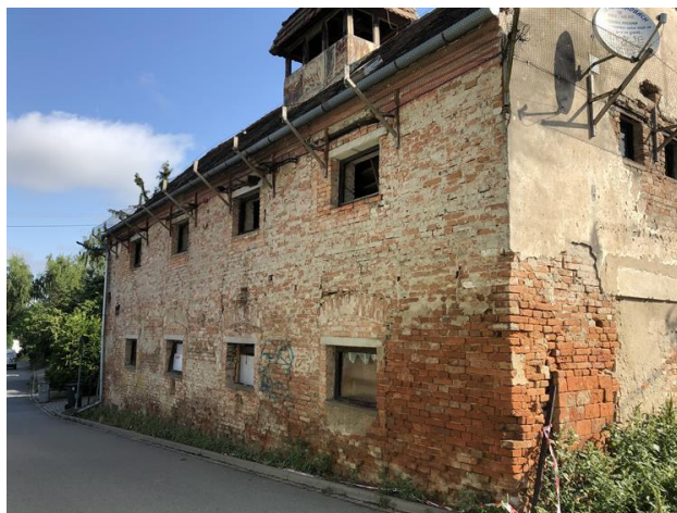
Objekt Střelnice před rekonstrukcí.
